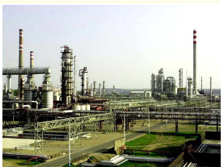
Obr. 12.3. Kolony pro destilaci ropy v Kralupské rafinerii. Rafinerie a petrochemické závody udržují z požárních důvodů značný rozestup mezi jednotlivými provozy.
