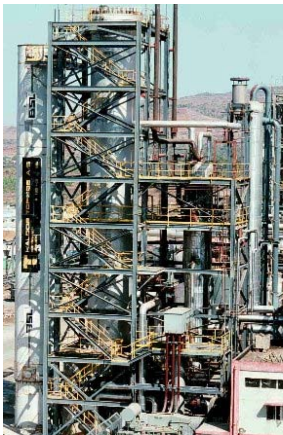
Obr. 4.3. Reaktor produkující 1500 t \text{NH}_3 /den. Obsahuje 250 t ( 100 \text{ m}^3 ) katalyzátoru
