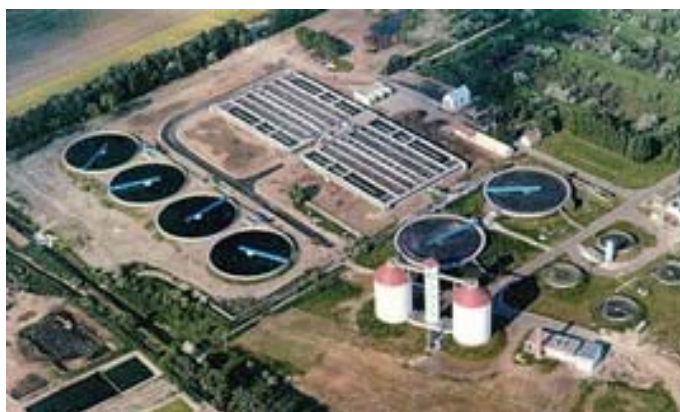
Obr. 9.6. Letecký pohled na čistírnu vody pro 200 tis. obyvatel. Aktivační nádrže obdélníkové vzadu. Kruhové Dorrovy dosazovaky. Uzávěrné válcové věže – vyhnívání
