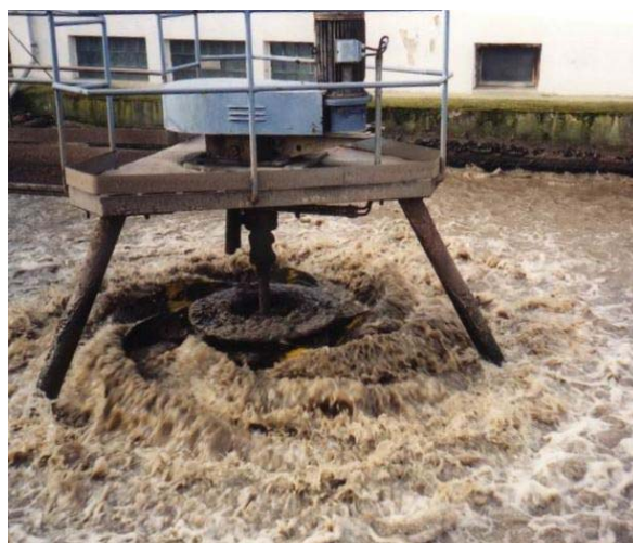
Obr. 9.4. Aktivační nádrž provzdušňovaná povrchovým míchadlem
