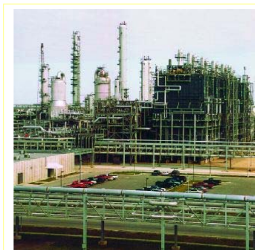
Obr.13.1. Výrobní ethylenu. Krakovací jednotka je uvnitř konstrukce napravo, destilační kolony v pozadí slouží pro separaci produktů.
