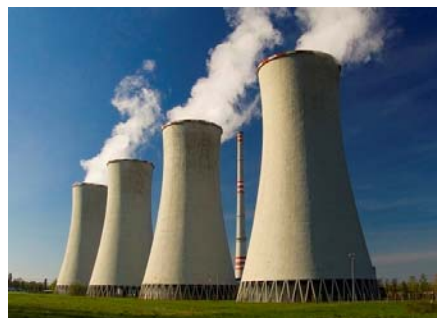
Obr. 9.1. Chladicí věž. V dolní části je mřížoví, kroupené chlazenou vodu. Lehčí horký vlhký vzduch stoupá vzhůru a přisává spodem nový suchý vzduch. (Dětmarovická elektrárna)
