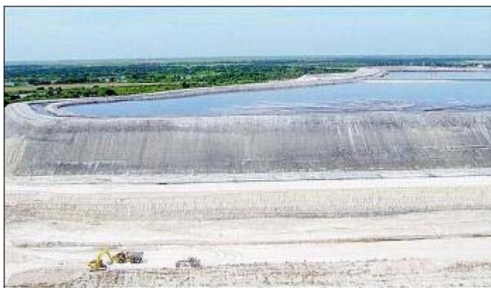
Obr. 6.1. Skládka odpadní fosfosádry kolem laguny s vodou, obsahující zbytky kyseliny (Florida, USA)
