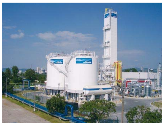
Obr.2.1 Zásobníky kapalného kyslíku a Lindeho kolona
