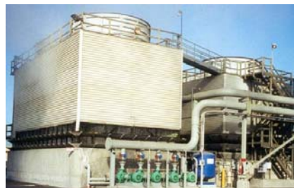
Obr. 9.2. Energeticky náročnější avšak prostorově menší chladiče mají v kratších komínkách umístěny vrtulové ventilátory
