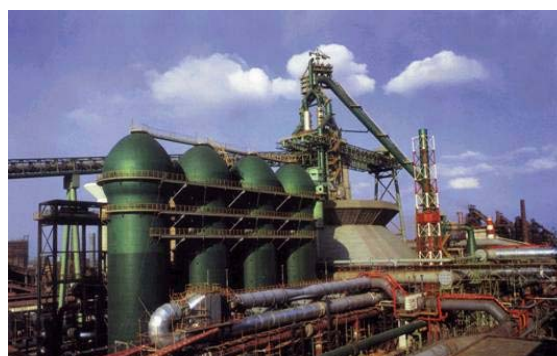
Obr. 8.1. Vysoká pec v pozadí, zprava k ní vede výťah na kusové suroviny, vepředu 4 cowperry pro
