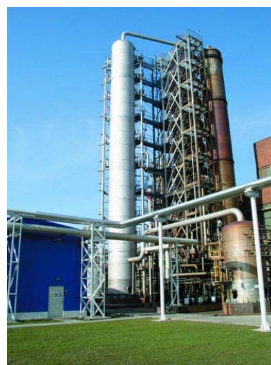
Obr. 4.5. Absorpční věže výroby HNO 3 (BC MCHZ Ostrava)
